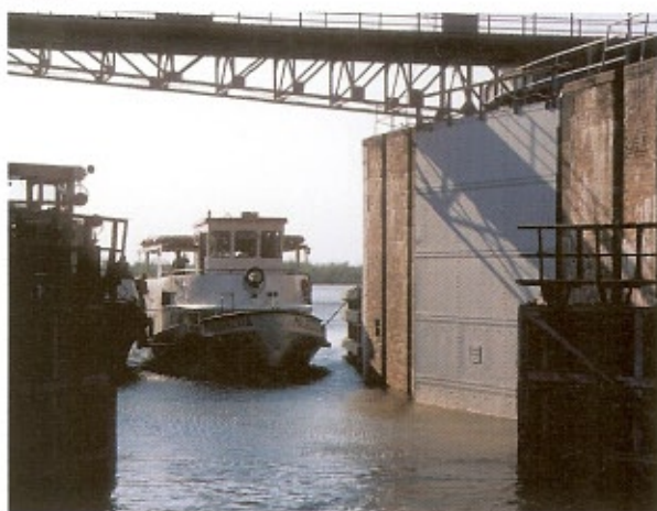
The sluice Gdańska Głowa (a Head of Gdańsk) in Żuławy
