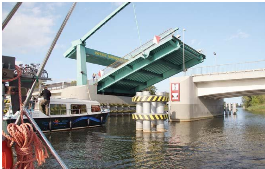
Kolejny most nad Szarpawą.
