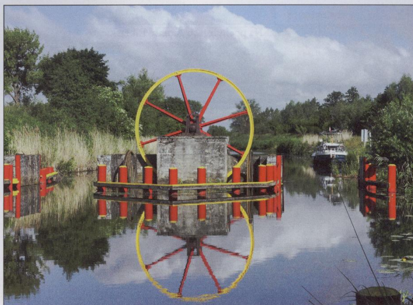
■ Wpływamy na pochylnię. W centrum widoczne koło zwrotne liny ciągnącej wózek...
