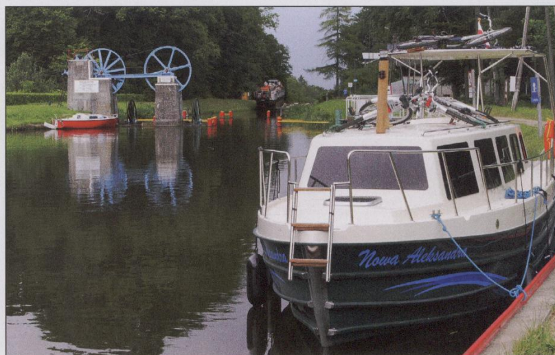
■ U góry pochylni koło napędzające linę i maszynownia. W dali statek na wózku jedzie już po lądzie
